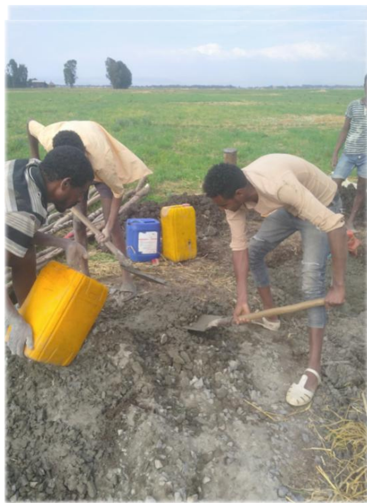
コンクリート練り
