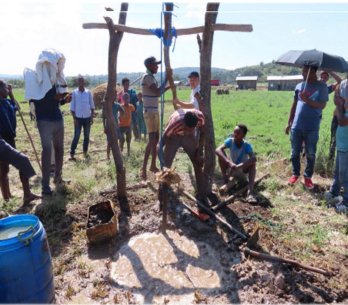
人力での井戸掘り
